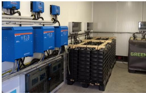
*Drei Batterie-Einheiten (am Boden) mit Anschlussbox. Links (blau): Drei Wechselrichter, darüber die Laderegler für die PV-Anlage. • Quelle: Bluesky Energy*
